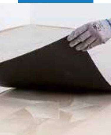
: Inštalácia krytiny LVT s lepidlom Ultrabond Eco 4 LVT
