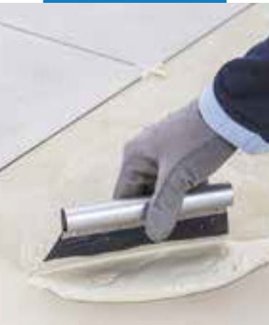
Nanesenie lepidla Ultrabond Eco 4 LVT a inštalácia krytiny LVT so širšou škárou
